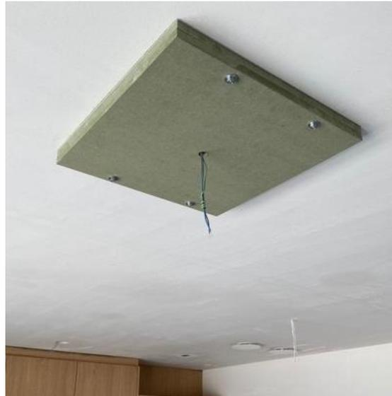
Dans le cas d'un plafond en béton, la lampe peut être fixée directement dans le béton.
